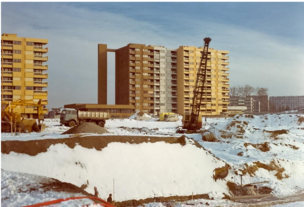
Construction de l'école des Champs-Frêchets: terrassements, décembre 1973
