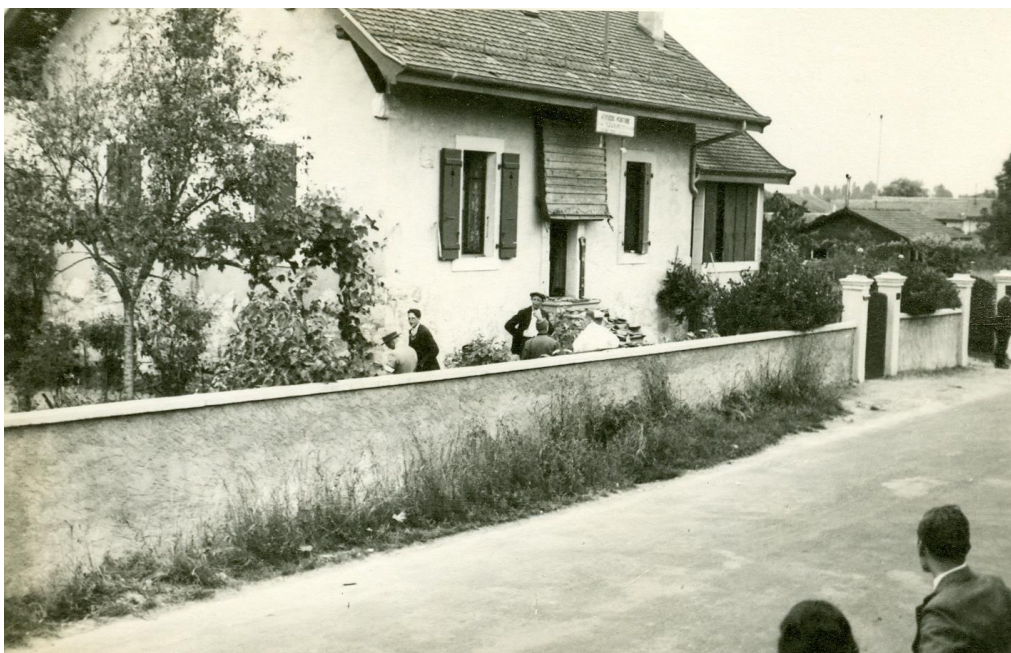
La maison de V. Zaninetti et la marquise endommagée. Collection Gilbert Daems
