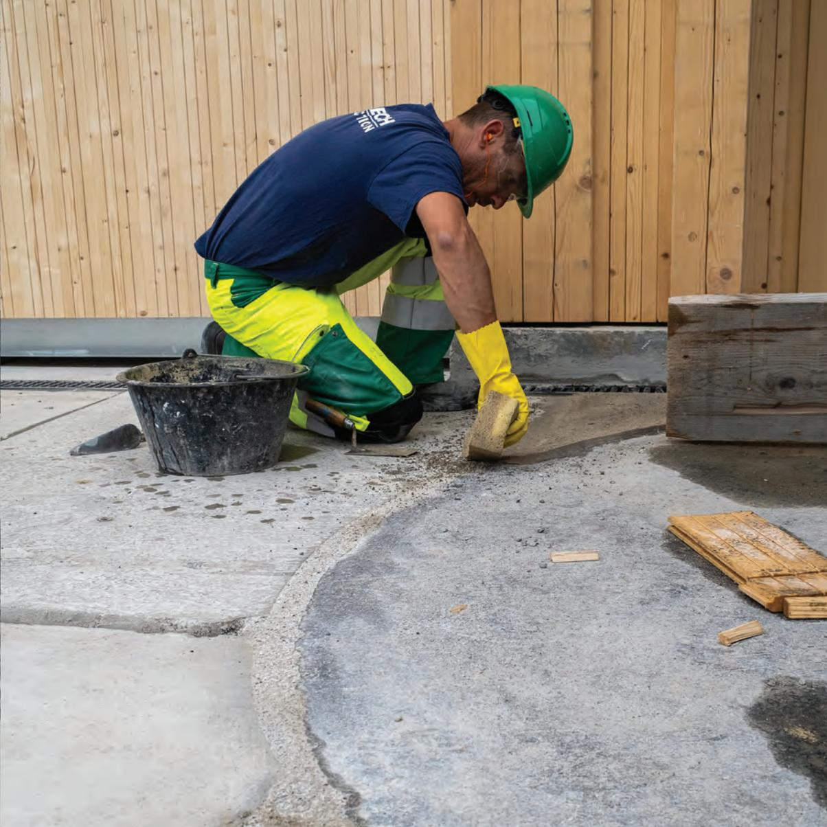
*“FAZ architectes réalise un travail remarquable de réemploi de béton issu de démolition. Par un calepinage savant, des morceaux de dalles et murs sciés sont mis en œuvre pour constituer le sol du lieu.”*
