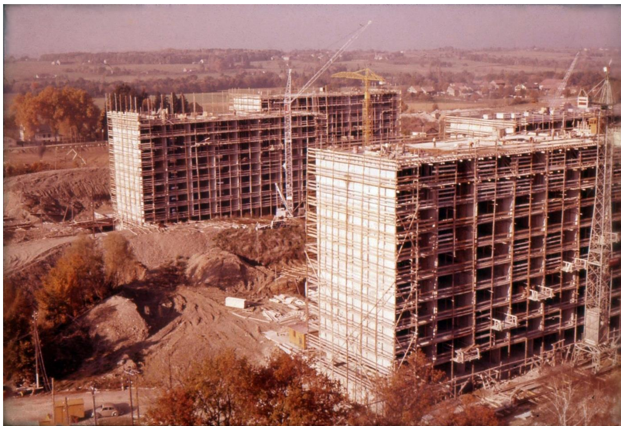
La Cité en construction, 1960-1961. Photo W. Rutz. ACM, D-RU-065
