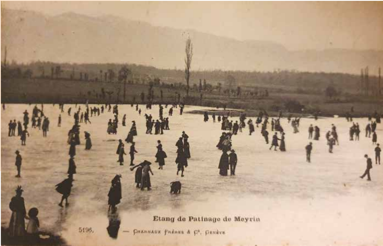
étang de patinage, 1902, Charnaux © ACM
