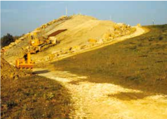
La Butte de Riantbosson en construction, 1985
