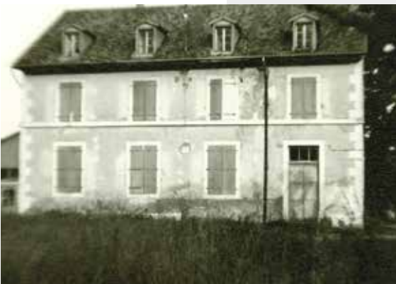
Actuelle Maison Vaudagne (av. de Vaudagne 16), années 60 [ce n'était alors pas encore la Maison Vaudagne. Le bâtiment logeait des saisonniers]
