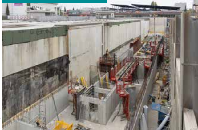
Construction des abris PC
