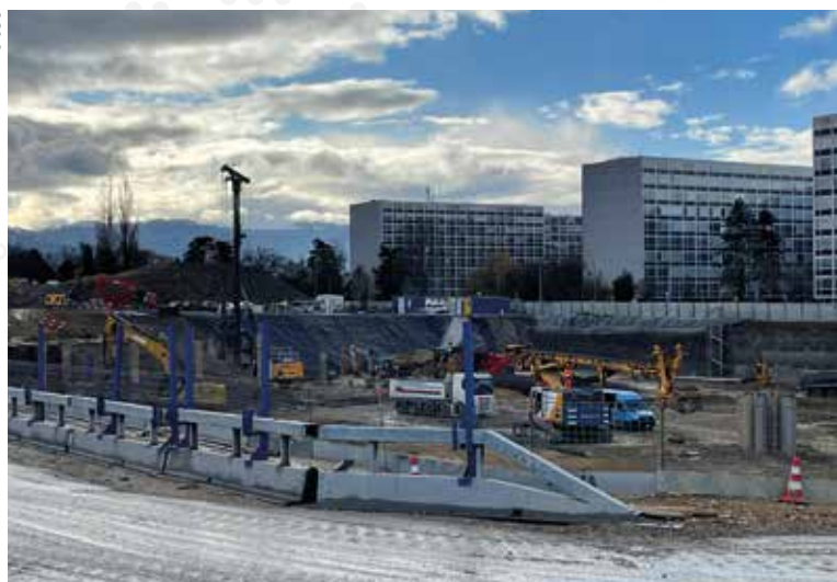
Site de la Gravière - établissement scolaire Noëlla-Rouget
