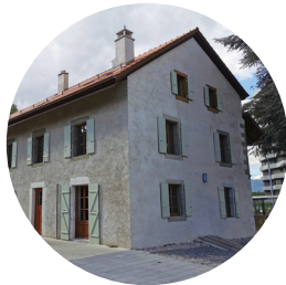
FERME DE LA PLANCHE ARCHITECTE INCONNU, 1820 > Avenue Jacob-Daniel-Maillard 4 P. 8-9
