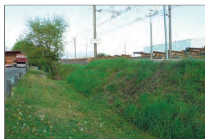
Talus CFF - Zone industrielle
