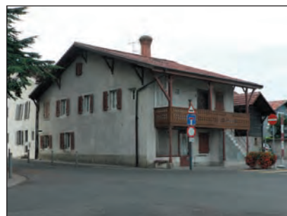
Angle nord ch. du Bournoud, - av. Malnati
