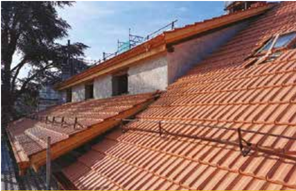
Rénovation Ferme de la Planche - Toiture rénovée
