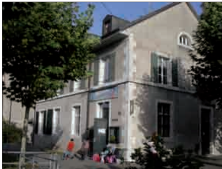
■ Ancienne école primaire transformée en centre de loisirs.
