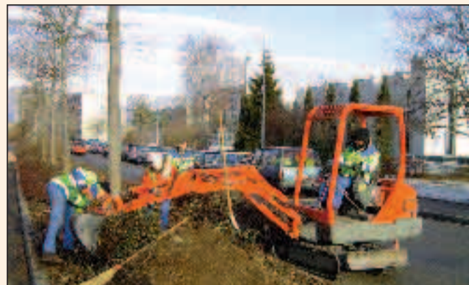
■ Préparation du système racinaire en vue du déplacement de l'arbre.
