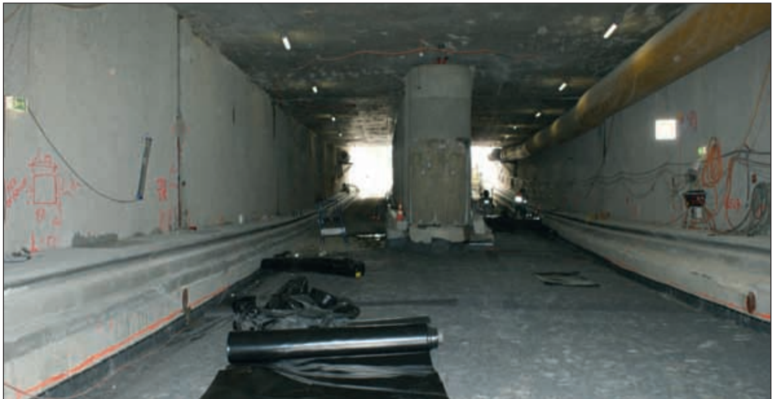
■ Une moquette de protection forme le fond de la chaussée avant d'être recouverte de tout-venant et du bitume de la route.
