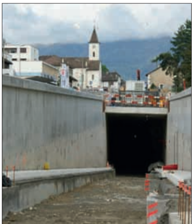
■ Entrée de la tranchée couverte côté ville.
