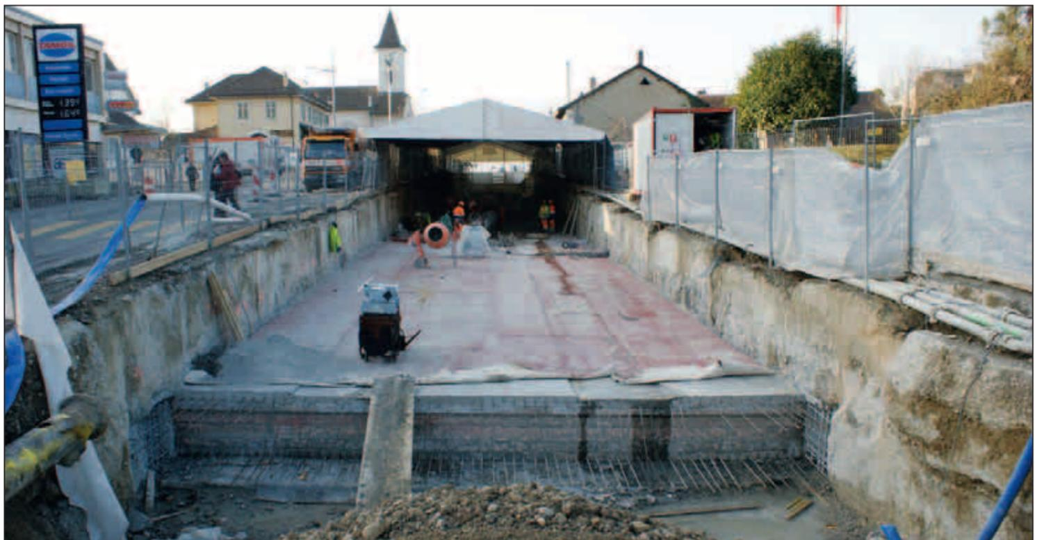
■ Vue impressionnante de la tranchée où l'on a coulé la dalle supérieure du tunnel.
