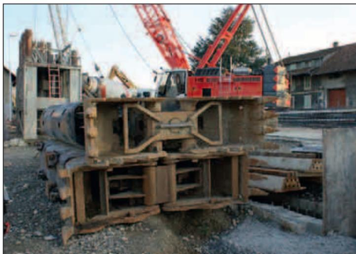
■ Les machoirs d'acier de 60 et 80cm de large qui creusent les murs latéraux de l'ouvrage.
