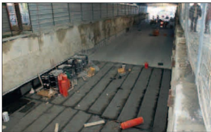
■ L'étanchéité de la dalle supérieure est assurée par plusieurs couches d'isolant.
