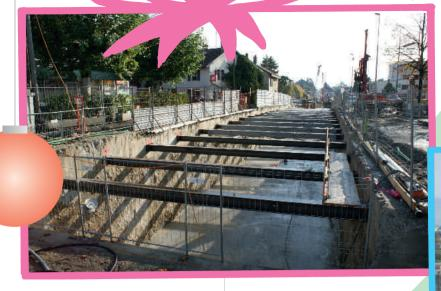
Le percement de la tranchée couverte de Meyrin-Village. Une dalle provisoire a été posée afin de protéger les hommes et les machines qui creuseront en dessous.
