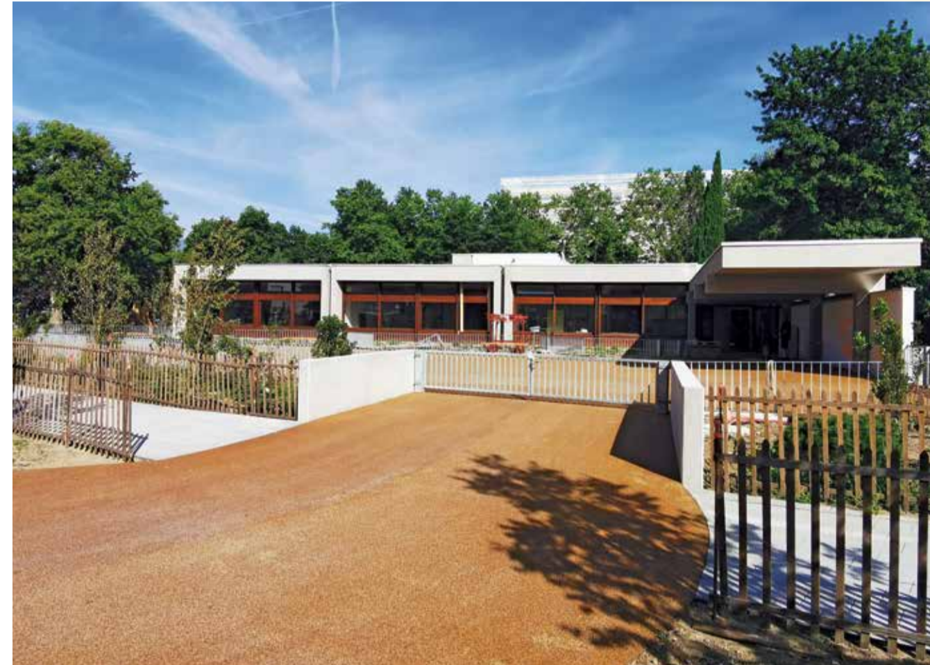
Cheminement rue de la Golette et façade
