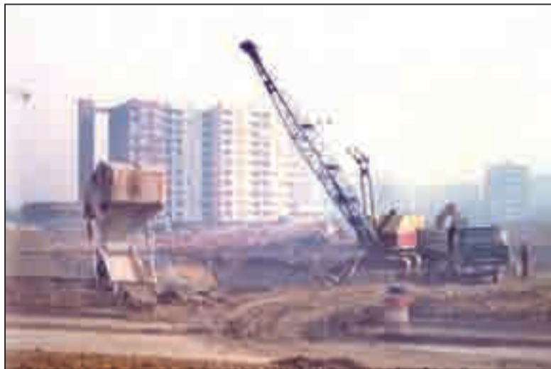
■ Les travaux de terrassement en décembre 1973.
