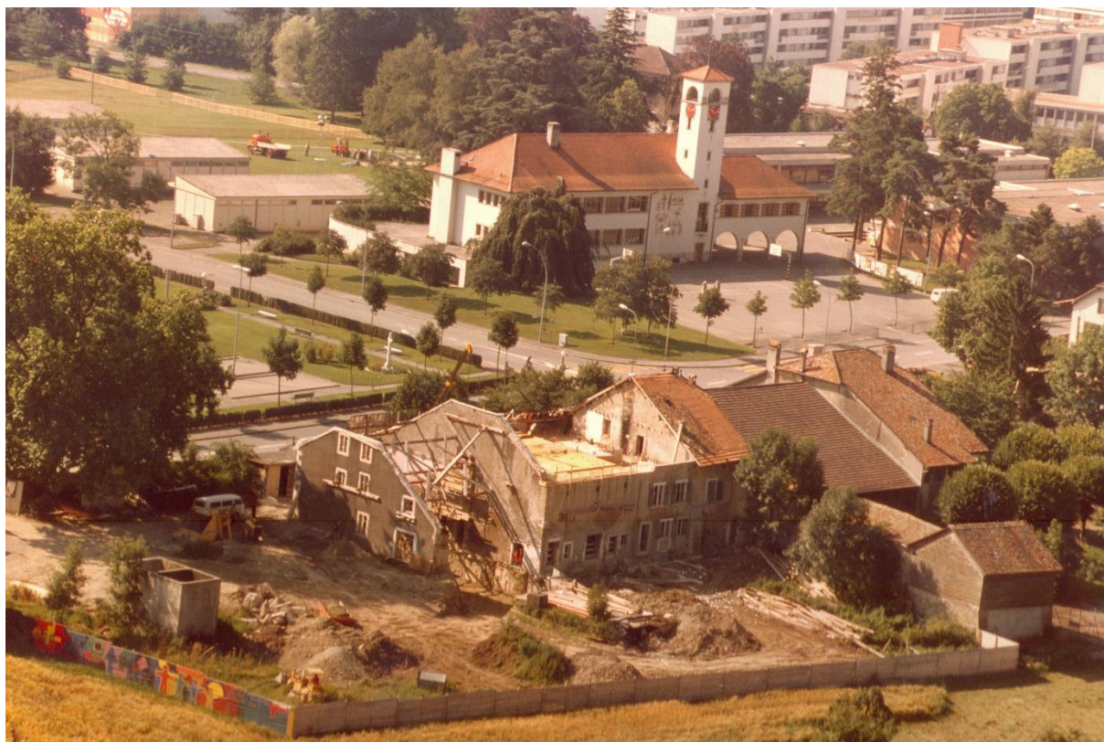
La ferme Rey en plein travaux. 1981. ACM.
