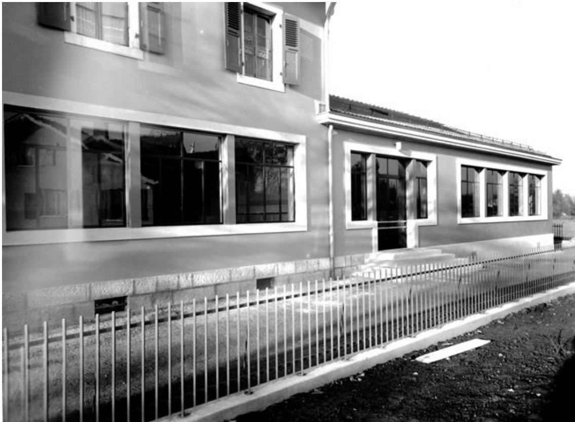
L'école secondaire et enfantine de Meyrin-Gare en 1937, juste après les travaux d'agrandissement. Photos ACM.
