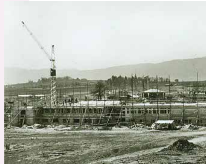
Construction du CERN, fin des années 50. Collection Ch. Noir.
