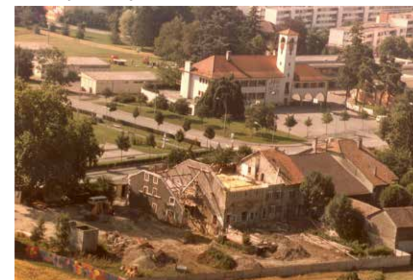
La ferme Rey en 1981, en plein travaux
